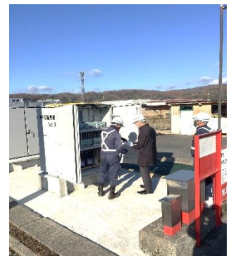
経営トップによる現場巡視
