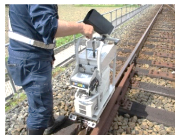
レール探傷器による作業
